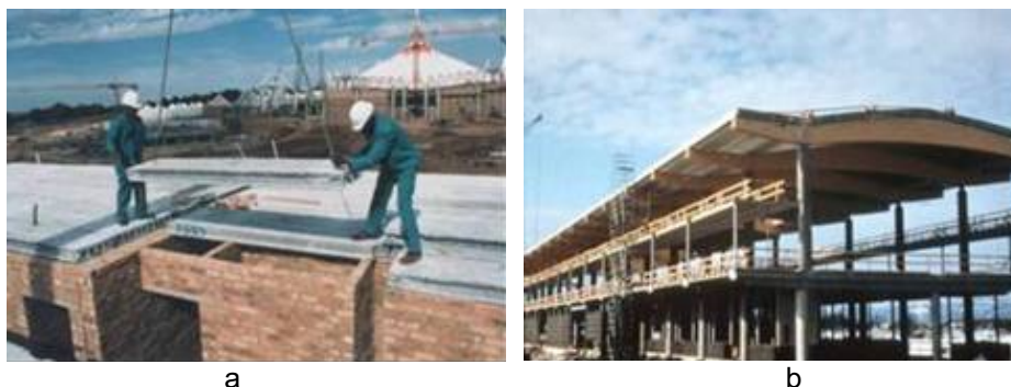
Figura 2 – Aplicação de unidades alveolares sobre alvenaria estrutural (África do Sul, 2001); b) Aplicação de unidades alveolares sobre estrutura de madeira (Finlândia, 2005). Fonte: FERREIRA (2007).
