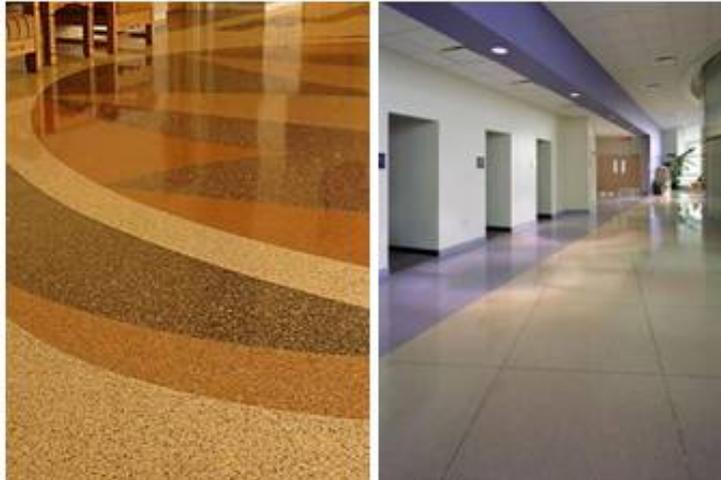
Figura 1 – Revestimentos em granilite. Fonte: NTMA (2011).
