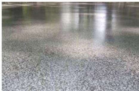
Figura 10 – Aspecto do granilite após os procedimentos de execução.
