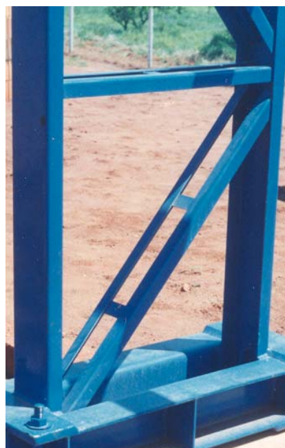
Figura 1 – Sistemas em dupla cantoneira simples com chapas separadoras
