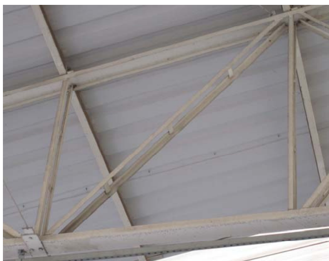
Figura 1 – Sistemas em dupla cantoneira simples com chapas separadoras
