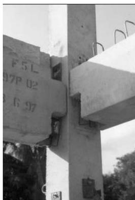
a) ligação viga-pilar de face – Tipo I
