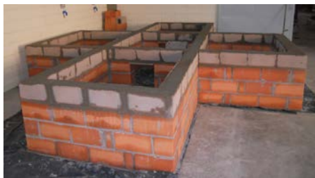
Figura 3 – Visão geral das paredes de sustentação.
