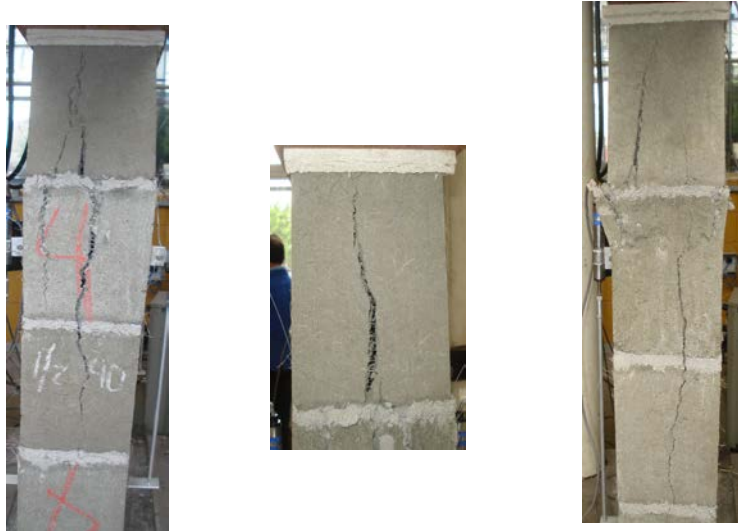
Figura 10 – Fissuras verticais ao longo dos septos laterais.
