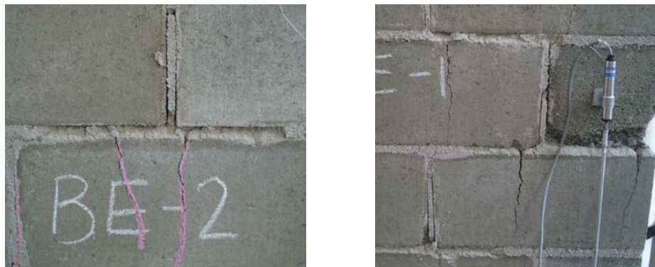
Figura 11 – Esmagamento da argamassa.
