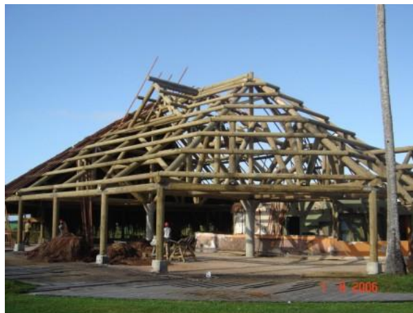
Estrutura de galpão e cobertura de treliças espaciais.
