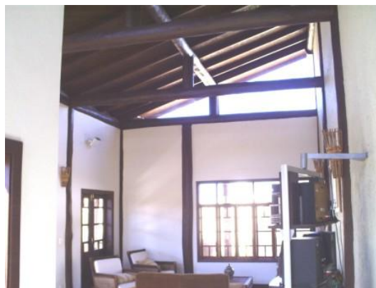
Vidro na cobertura para entrada de iluminação natural. Estrutura da cobertura da sala social.
