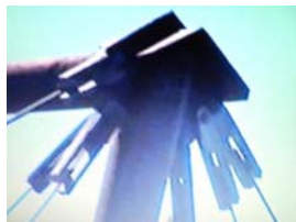
Placa de fixação dos estais.
