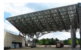
Vista da estrutura completa.
