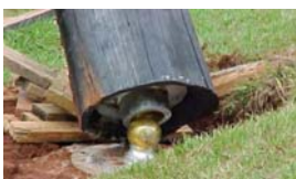
Posicionamento da base do poste na placa de base de aço articulada, chumbada no bloco de fundação.
