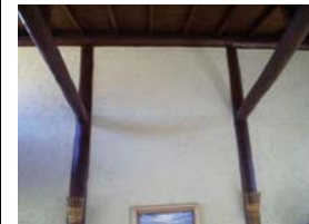
Estrutura da cobertura da sala social, e conexões viga-coluna, pé-direito duplo.
