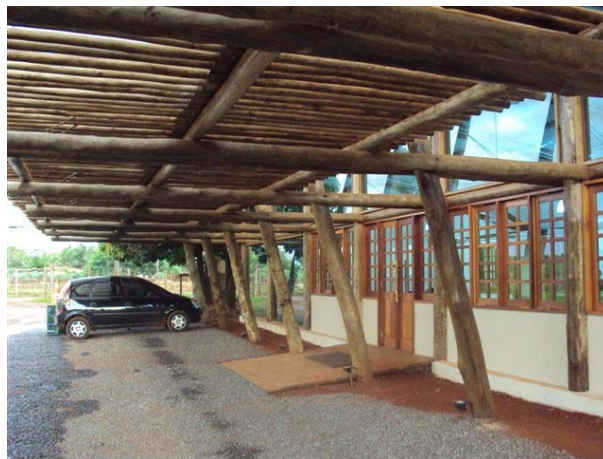
Pérgolas em balanço, sobre a área de estacionamento.
