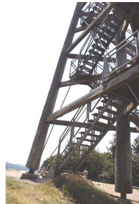
Colunas nas placas de base e nos blocos de fundações.
