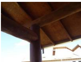
Conexão da coluna de canto da varanda na lateral esquerda.
