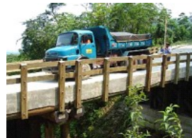
Prova de carga na lateral direita
