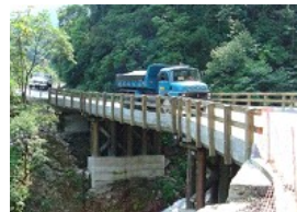
Prova de carga na lateral esquerda
