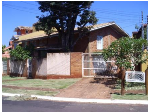
Fachada da edificação do sobrado do ateliê de artista plástico.
