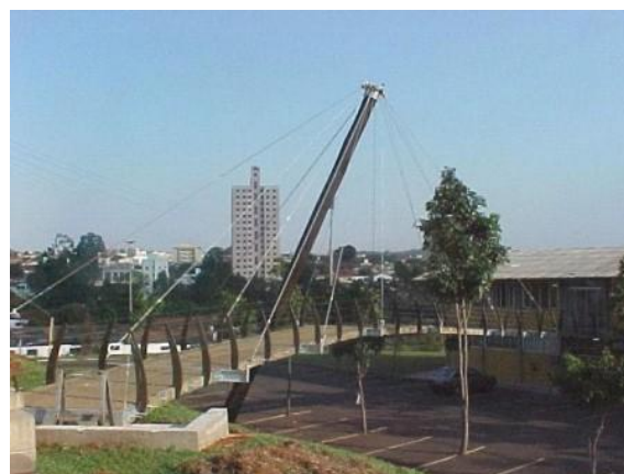
Vista da Passarela em curva protendida e estaiada.
