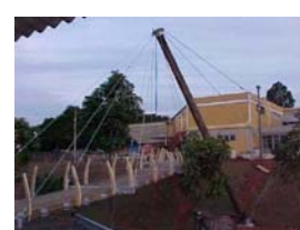
Colocação dos estaios.
