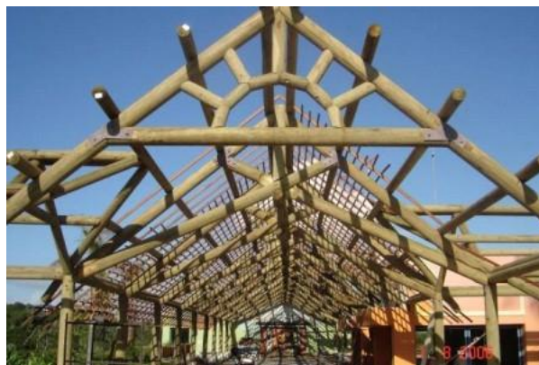
Pórtico rígido e treliças scissors.
