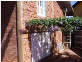
Ligação viga-coluna do pavineto superior.
