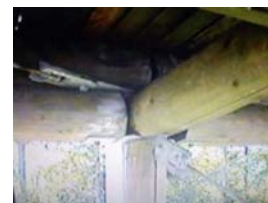
Ligações vigas-coluna da rampa de acesso.
