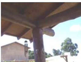
Conexão da coluna de canto da varanda à frente.
