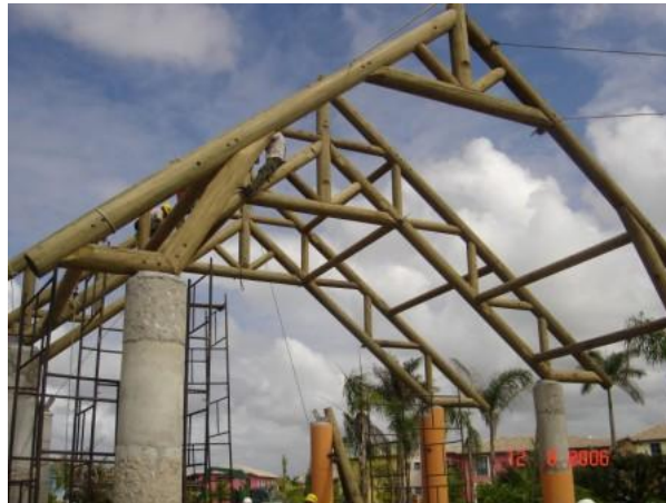
Pórtico Rígido e Vigas inclinadas em treliças.
