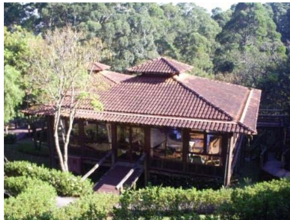
Vista do Pavilhão da Biblioteca (10mx10m).
