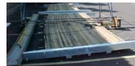
Aplicando protensão nos módulos do tabuleiro.
