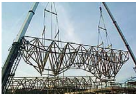
Processo de montagem da cobertura de treliça espacial.
