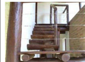
Patamar da escada.
