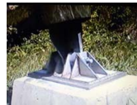
Placa de base de uma das colunas do pórtico .
