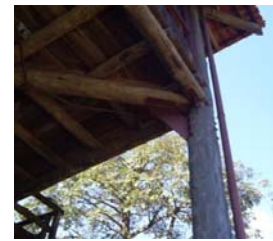
Detalhe da coluna de canto.
