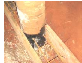
Barras de aço da viga baldrame, inseridas nas bases das colunas.
