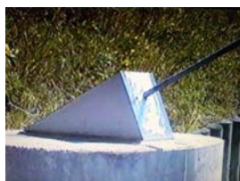
Vista lateral da placa de base de fixação dos estais.
