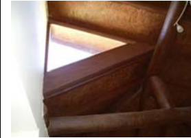
Estrutura da cobertura sobre a escada.
