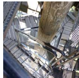
Coluna central que suporta parte do carga da escada.
