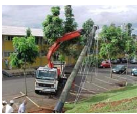
Içamento do Poste.
