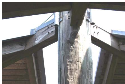
Ligações de Vigas Horizontais com a coluna.
