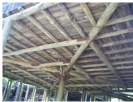
Grelha que compõe a estrutura do piso do Pavilhão Don Duane Willian.
