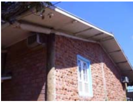
Ligação viga inclinada-coluna de canto, cobertura do pórtico.
