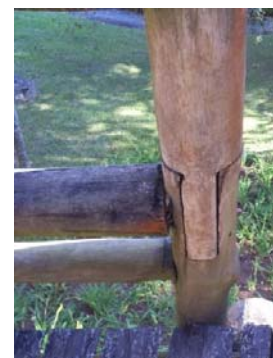
Emenda da coluna do guarda corpo.
