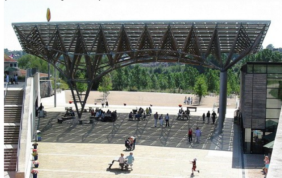
Vista frontal da estrutura completa.
