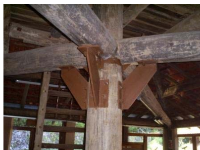
Conexões metálicas tipo consoles, que unem as vigas da estrutura da cobertura à coluna central.
