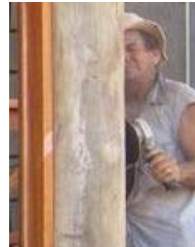
Lixamento dos elementos estruturais de madeira roliça. Preparo para aplicação de Osmocolor Stain da Montana Química.
