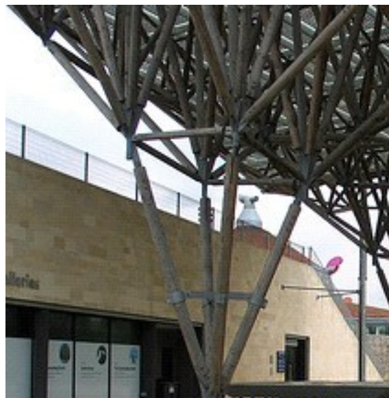
Estrutura de apoio da cobertura, com 4 colunas inclinadas em V, situada ao lado esquerdo da edificação.
