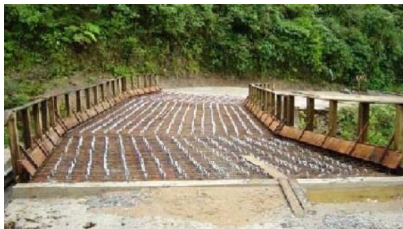
Vista superior do tabuleiro com os conectores metálicos
