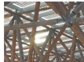
Detalhe das conexões da treliça espacial.
