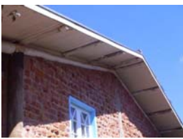
Treças da cobertura com madeira roliça de eucalipto.
