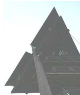
Vista inferior do patamar Principal.
