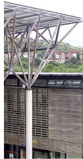
Detalhe da estrutura de treliça espacial da cobertura, fixada no topo da coluna de concreto armado, situada ao lado direito da edificação.
