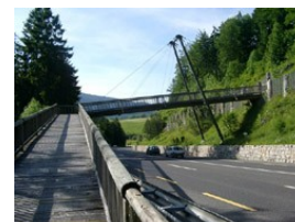
Vista da rampa da Passarela Estaiada
