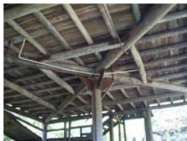
Detalhes das vigas fixadas na coluna central.
