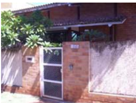
Cobertura da varanda.
