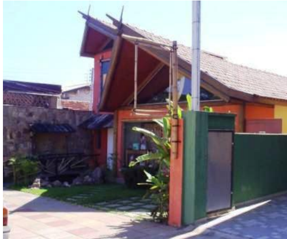
Fachada principal de edificação comercial para boutique. Fonte: Fotos do Autor em abril de 2009.
