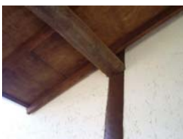
Conexão da coluna intermediária, da varanda com a sala social, na lateral esquerda.
