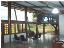
Vista interna do escritório. À direita escoras inclinadas definitivas (mãos francesas tridimensionais), sustentam a estrutura da cobertura do escritório.
