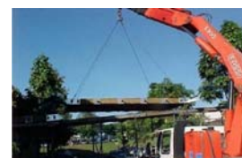
Instalação dos módulos do tabuleiro.
