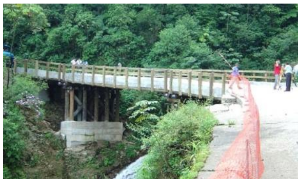
Vista da Ponte Caminho do Mar
