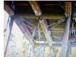
Contraventamentos horizontais e verticais.
