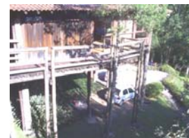
Estrutura da passarela externa.
