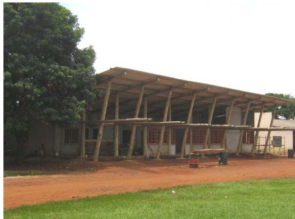
Fachada principal em fase final de construção.
