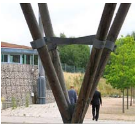
Detalhe do contraventamento da estrutura de apoio da cobertura, com 4 colunas inclinadas em V, situada ao lado esquerdo da edificação.
