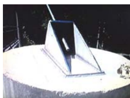
Vista frontal da placa de base de fixação dos estais.
