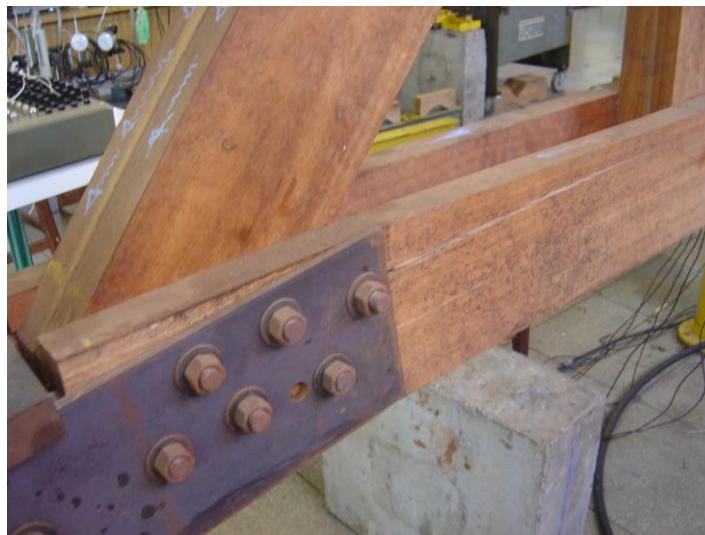
Figura 17 – Ruptura dos módulos na ligação do apoio.
